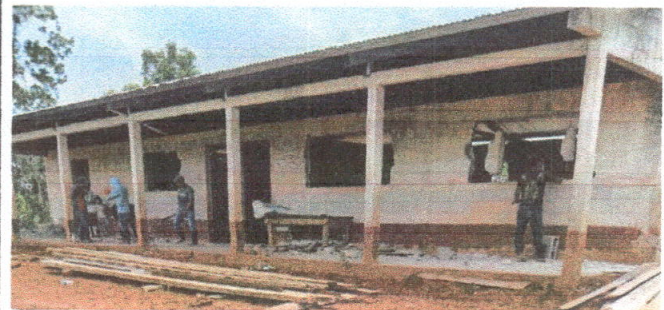
Foto 2: se logra apreciar el avance del cambio del piso del corredor.
