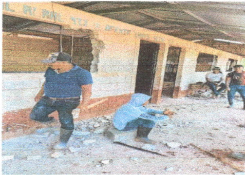
Foto1: se logra apreciar el avance de la modificacion de las ventanas.
