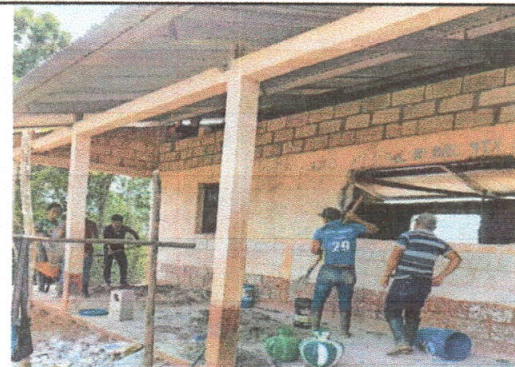
Foto 4: en la imagen se logra evidenciar el avance de la pintura en paredes.
