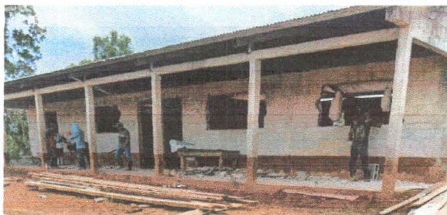
Foto 3: se logra apreciar el vance del cambio de ventanas.
